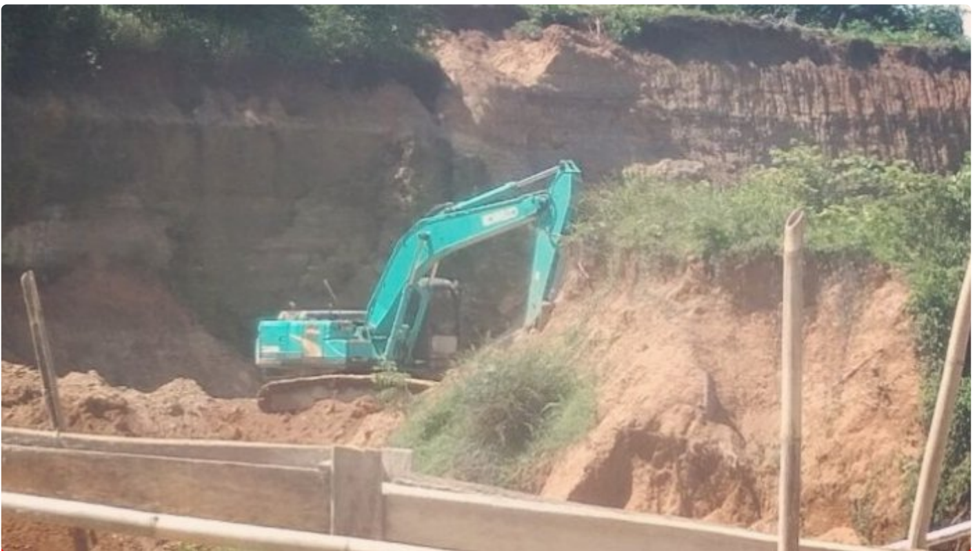
Nampak lokasi tambang pasir diduga ilegal dan menggunakan alat berat
